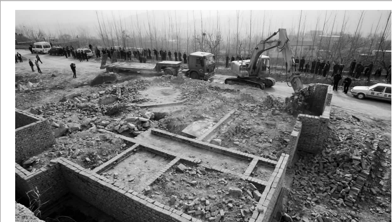
□记者 卢鹏 通讯员 刘伟 报道 12月2日，济南市仲宫镇开始南部山区冬季拆违，一天拆除6处共11000平方米。图为拆除锦绣川办事处杨家洼村拟建为单体老年公寓的一处违章建筑，共五栋基础，其中三栋建至一层墙体，面积1900平方米。这些违法违章建筑均无任何相关建设手续，存在严重安全隐患，违法占用耕地，影响城市规划。此次拆除行动共计出动300余人，拆除机械6台，执法车辆20余部。
