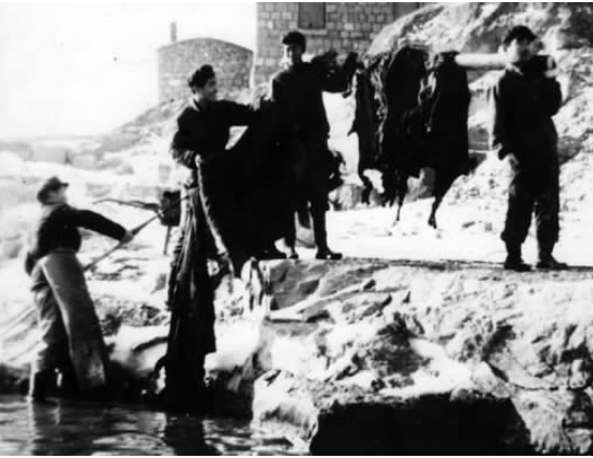
传统熬胶法: 数九寒天胶工在狼溪河破冰泡皮。
