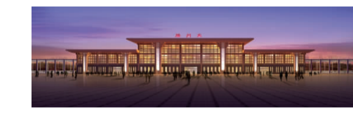
正在建设中的京沪高铁滕州站。
