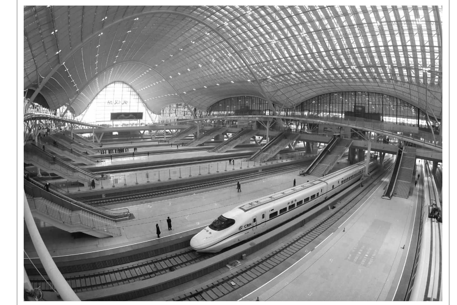
12月24日,宽敞大气的武汉火车站即将迎接武广高铁首批乘客。目前世界上一次建成里程最长、运营速度最快的高速铁路——武广高铁客运新干线的节点工程武汉火车站建设正进入通车前的最后冲刺阶段,可望按计划于12月26日投入运营。武汉火车站和广州南站是目前国内现代化程度最高、规模最大的两个火车站,分别设有高速和普通两个车场,其特大型客运站图形布置均为世界首创。
