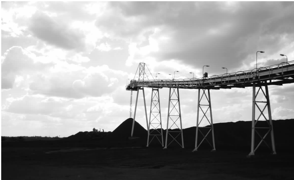
正在建设中的菲利克斯公司露天煤矿
