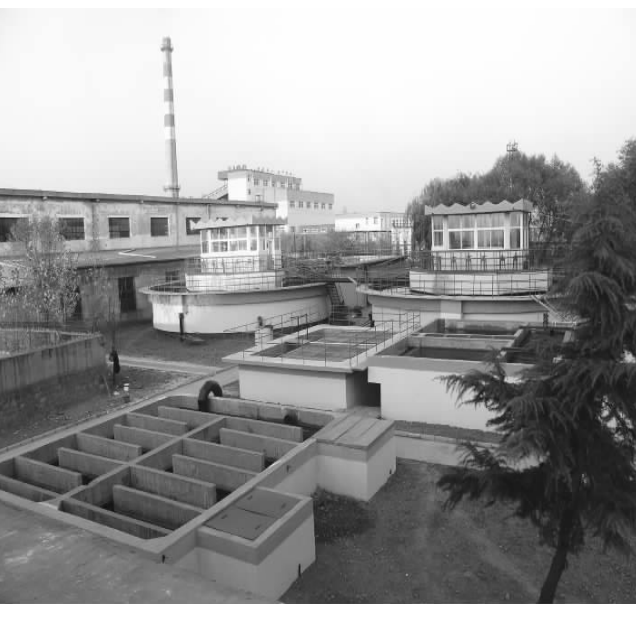
翟镇污水处理厂全景
