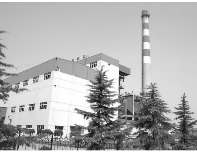
翟镇煤矿以废弃矸石为原料，建成了装机容量6000KW的矸石电厂
