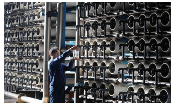
2008年12月1日，在太原钢铁(集团)有限公司的污水处理作业区，一名工人正在取样。2009年上半年，山西做出了“黑”转“绿”的抉择：上半年，山西省万元工业增加值能耗下降7.92%，万元GDP电耗下降8.54%，二氧化硫减排量超额完成了“十一五”目标。
