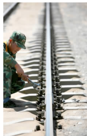
酒泉卫星发射中心铁路管理处“70公里”点的巡道兵胡文俊在检查铁路线。
