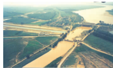
渠首打渔张引黄闸。
