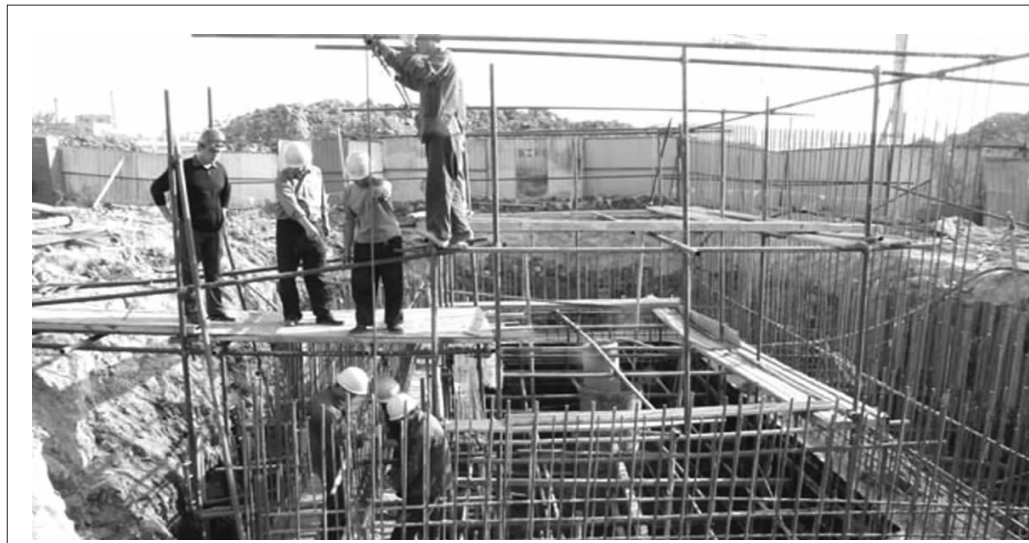
小清河区域供水管线南北贯通
