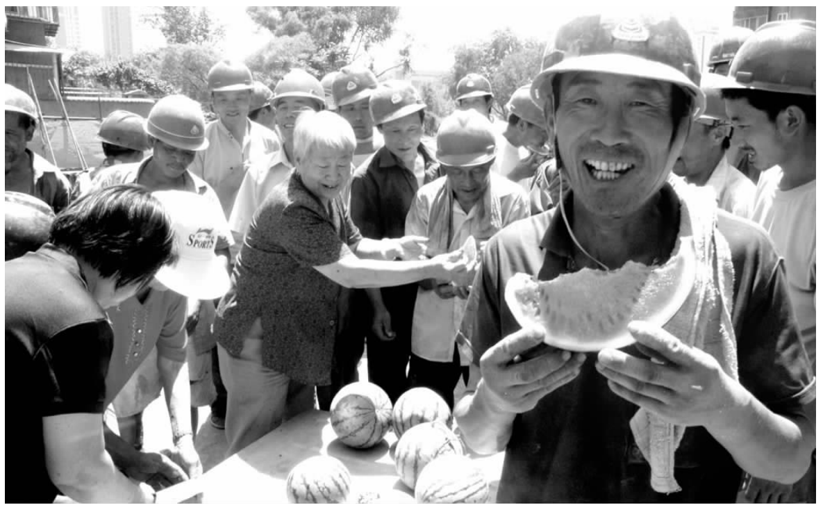
高温天里送清凉 6月24日，淄博市气温高达37℃以上，张店区公园办事处西苑社区十几名老党员、社区居民，来到该市重点工程——猪龙河二期工程施工现场，为工人和管理人员送来西瓜和绿豆汤。
