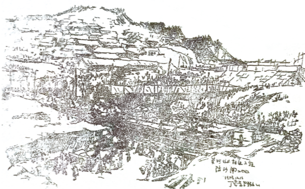
(图四)防沙闸工地 丁宁原
