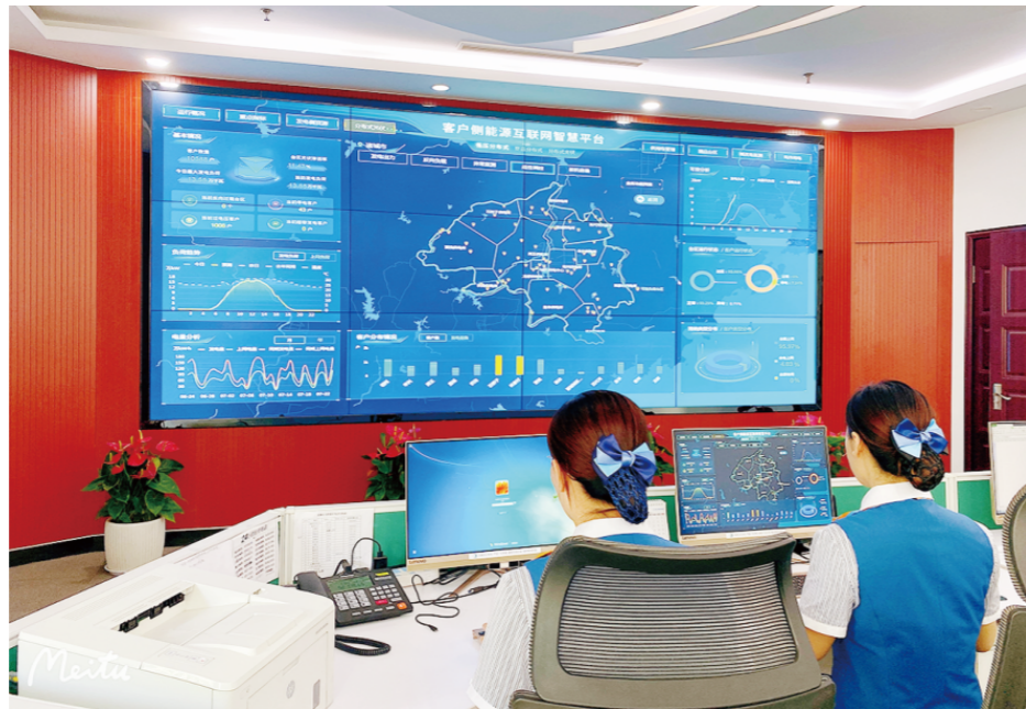
国网诸城供电公司新能源数字化监控中心。
