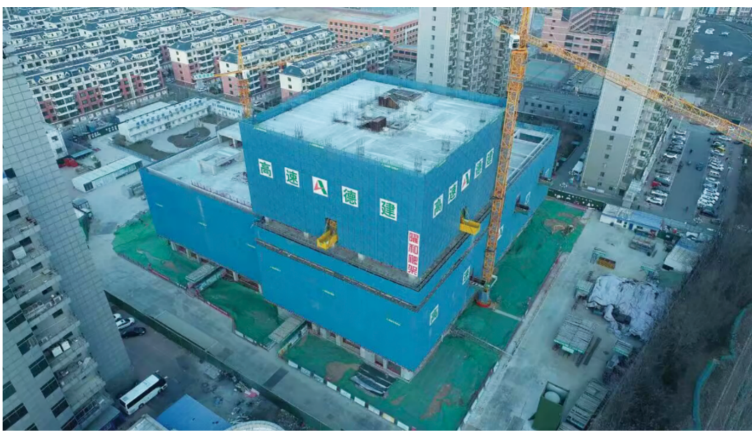
山东高速德建集团承建的山东新华书店集团鲁北发行中心项目。
