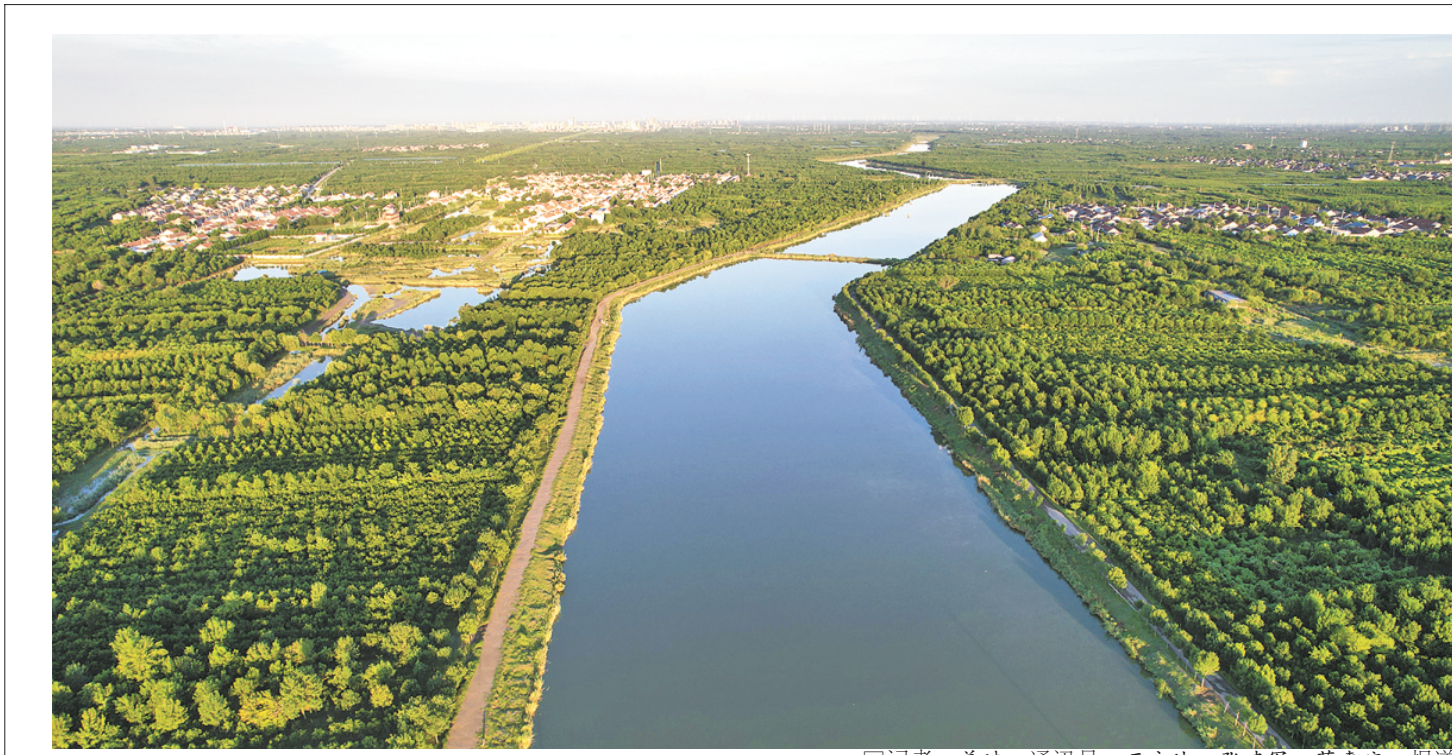
□记者 姜斌 通讯员 王永波 张建军 蒋惠庆 报道 堤岸岸绿，水鸟翩翩起舞，这是无棣县今年开展朱龙河美丽幸福示范河湖建设工程带来的新变化。朱龙河是无棣一条骨干排涝河道，当地高度重视美丽示范河湖创建工作，沿线54名县镇村级河长履职尽责，对2020年完成清淤疏浚工程后的坝顶岸上平整，河坡上的雨冲沟进行回填，边坡整理，河道边坡撒播植草，形成一条集观赏、休闲、旅游为一体的城镇田园生态长廊。
