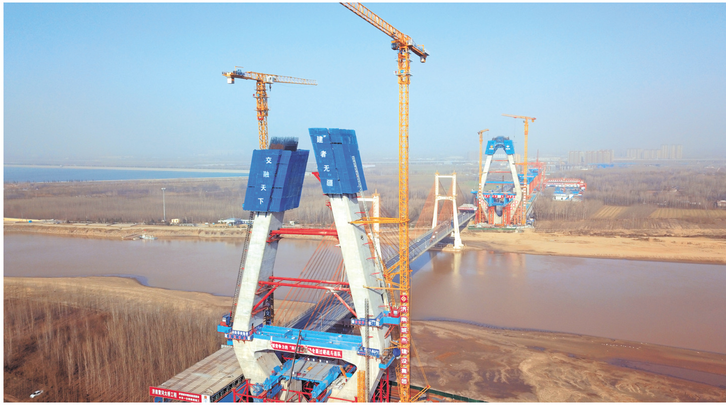
济南黄河公路大桥扩建工程新建黄河大桥节段攀升，目前正在行上部结构施工，助推济南加快“拥河发展”步伐。
