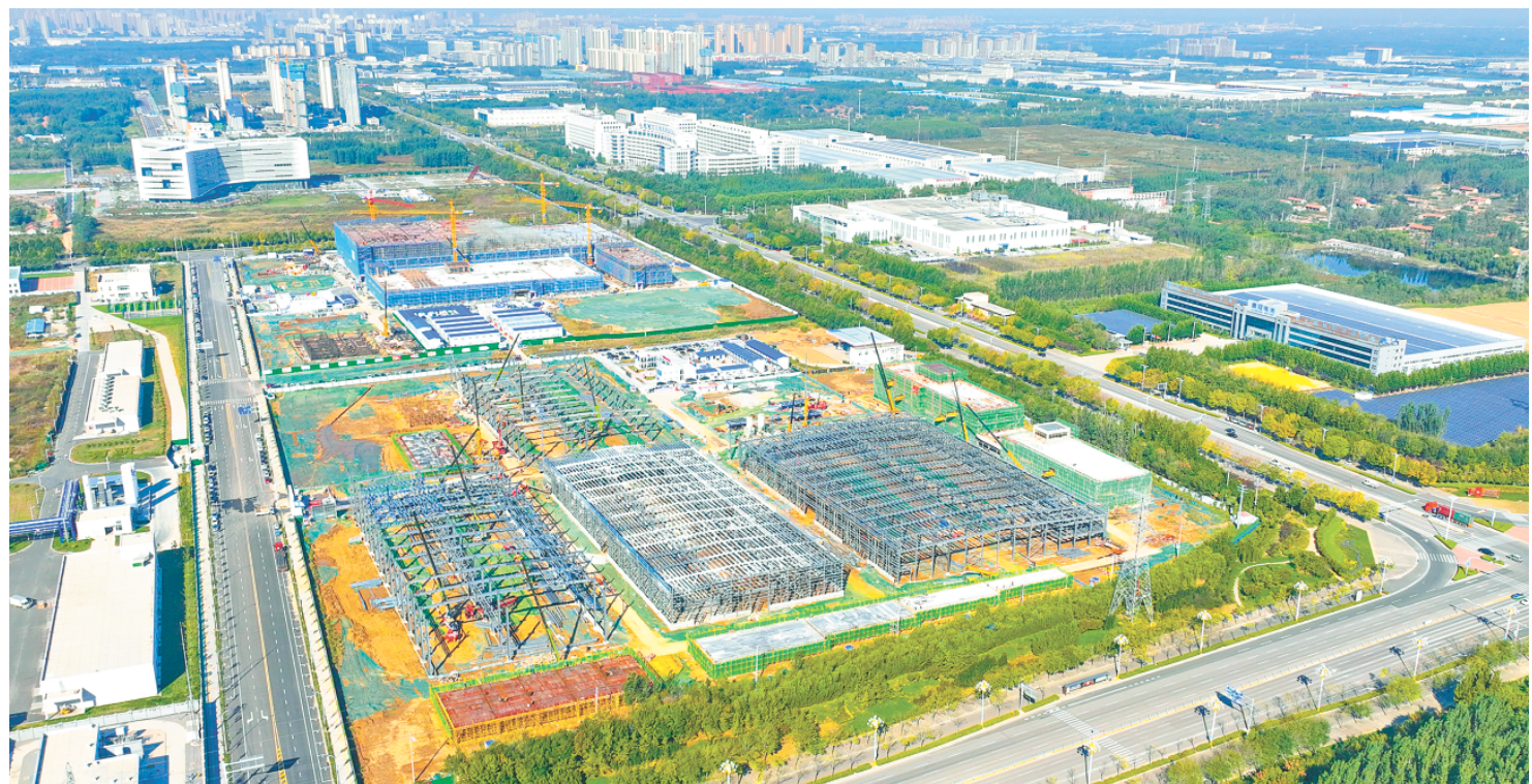
图为建设中的有研艾斯和有研亿金项目现场。
