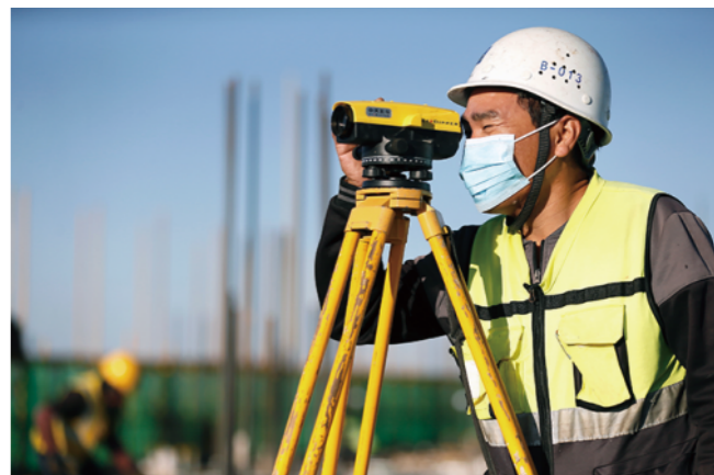
放线员屏气凝神，使用水平仪测量建筑标高。
