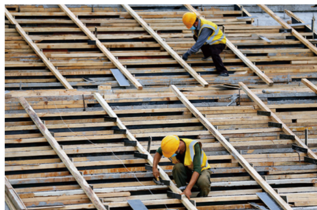
木工聚精会神搭建楼梯模板。
