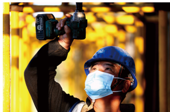
架子工用电动工具拧螺丝固定脚手架。每一个螺丝都关乎安全，容不得半点马虎。
