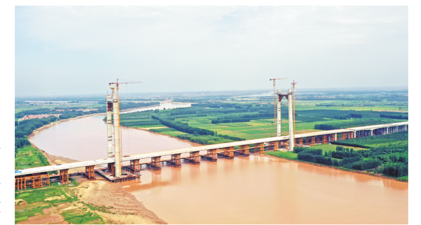
沾化至临淄高速公路黄河特大桥施工现场，桥梁结构清晰可见。
