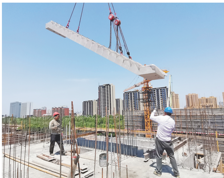
在潍坊市寒亭区和园小区施工现场,工人正在装配预制楼梯。(□记者 张鹏 报道)
