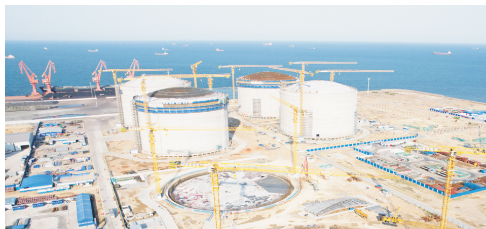
龙口LNG接收站施工现场。
