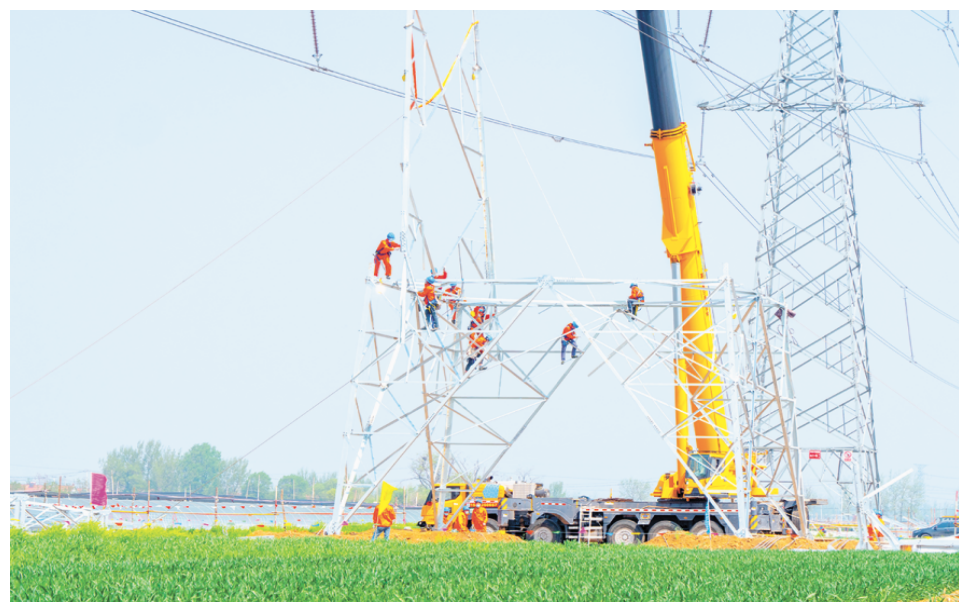
潍坊—烟台220千伏线路改造施工现场。
