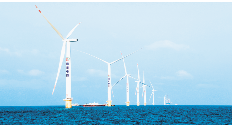
国家电投山东半岛南3号海上风电项目。
