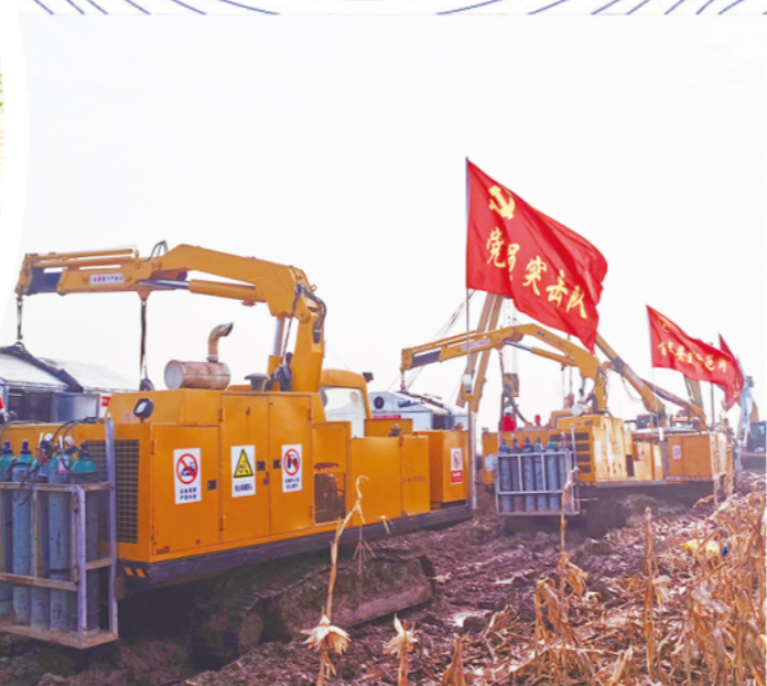
鲁信集团承建的山东天然气环网西干线项目现场
