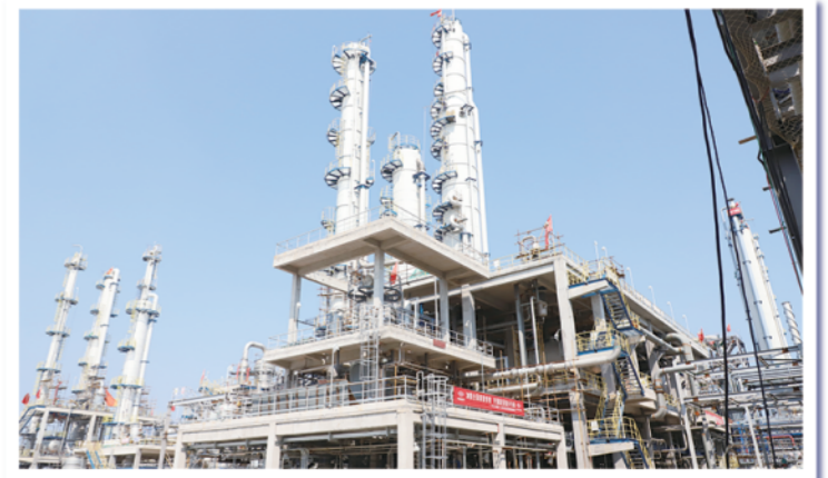
打破国外垄断的天辰集团己二腈项目进展顺利
