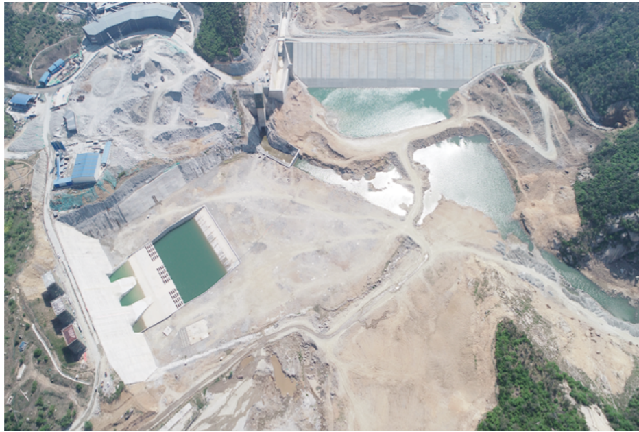
文登抽水蓄能电站下水库。
