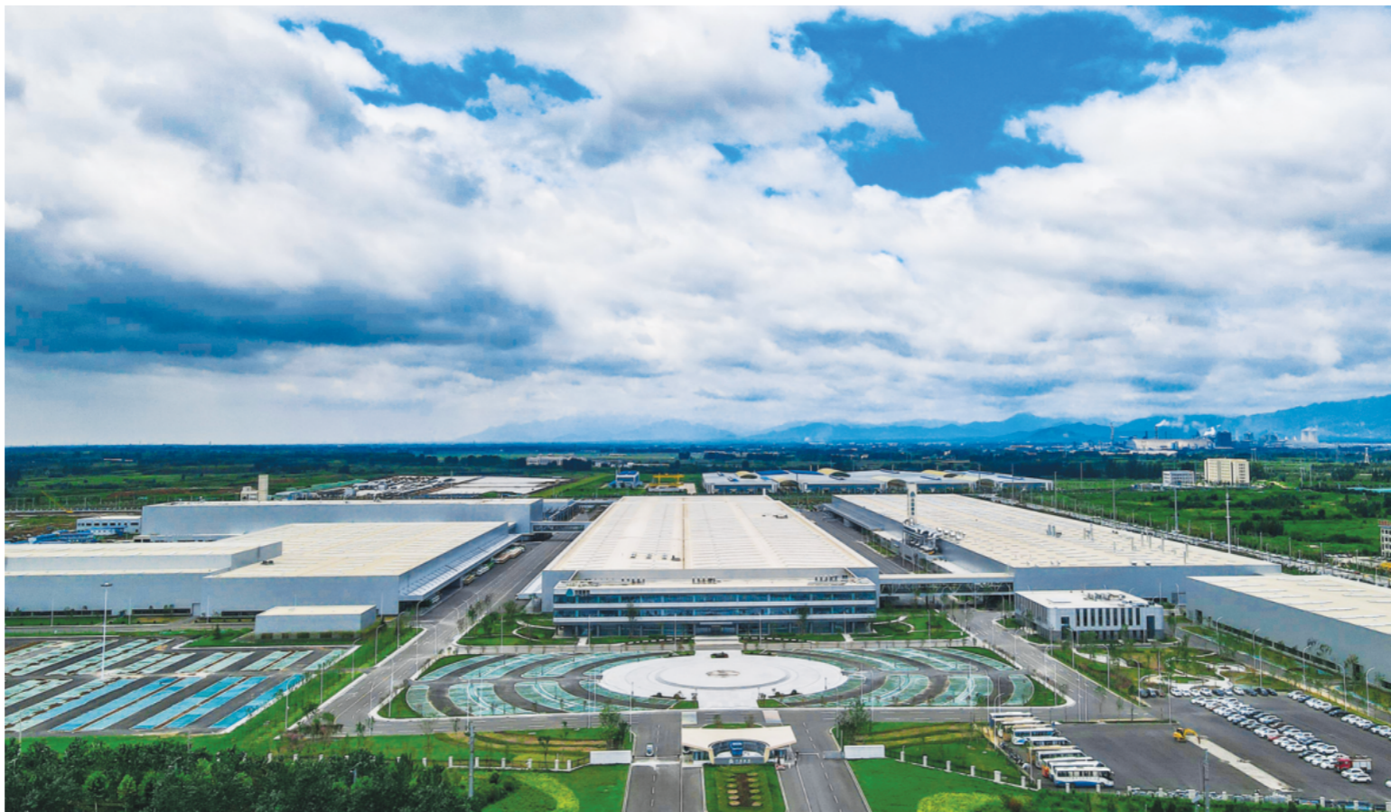
作为“链主”企业，山东重工绿色智造产业城正在加速崛起，引领全产业链升级完善。
