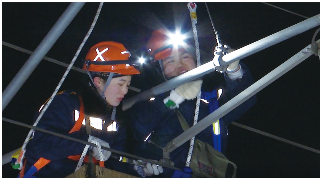
车梯女孩在黄河公铁两用特大桥进行检修作业。
