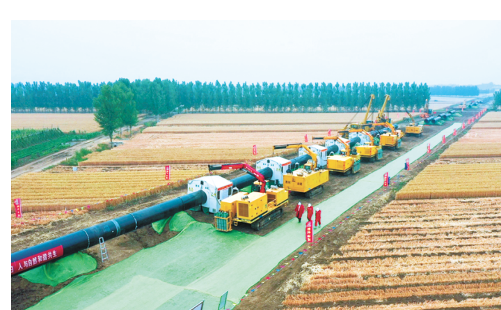
山东天然气环网南干线施工现场。 □刘振 报道
