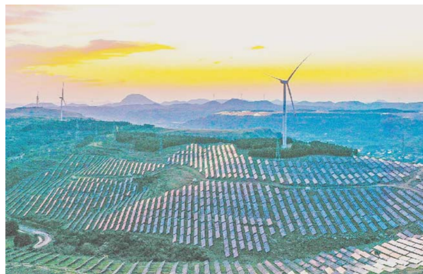
▲枣庄山亭区徐庄镇风光发电项目
