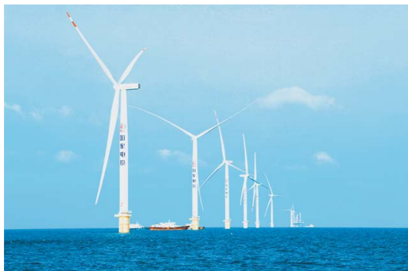
▲国家电投山东半岛南3号海上风电风机
