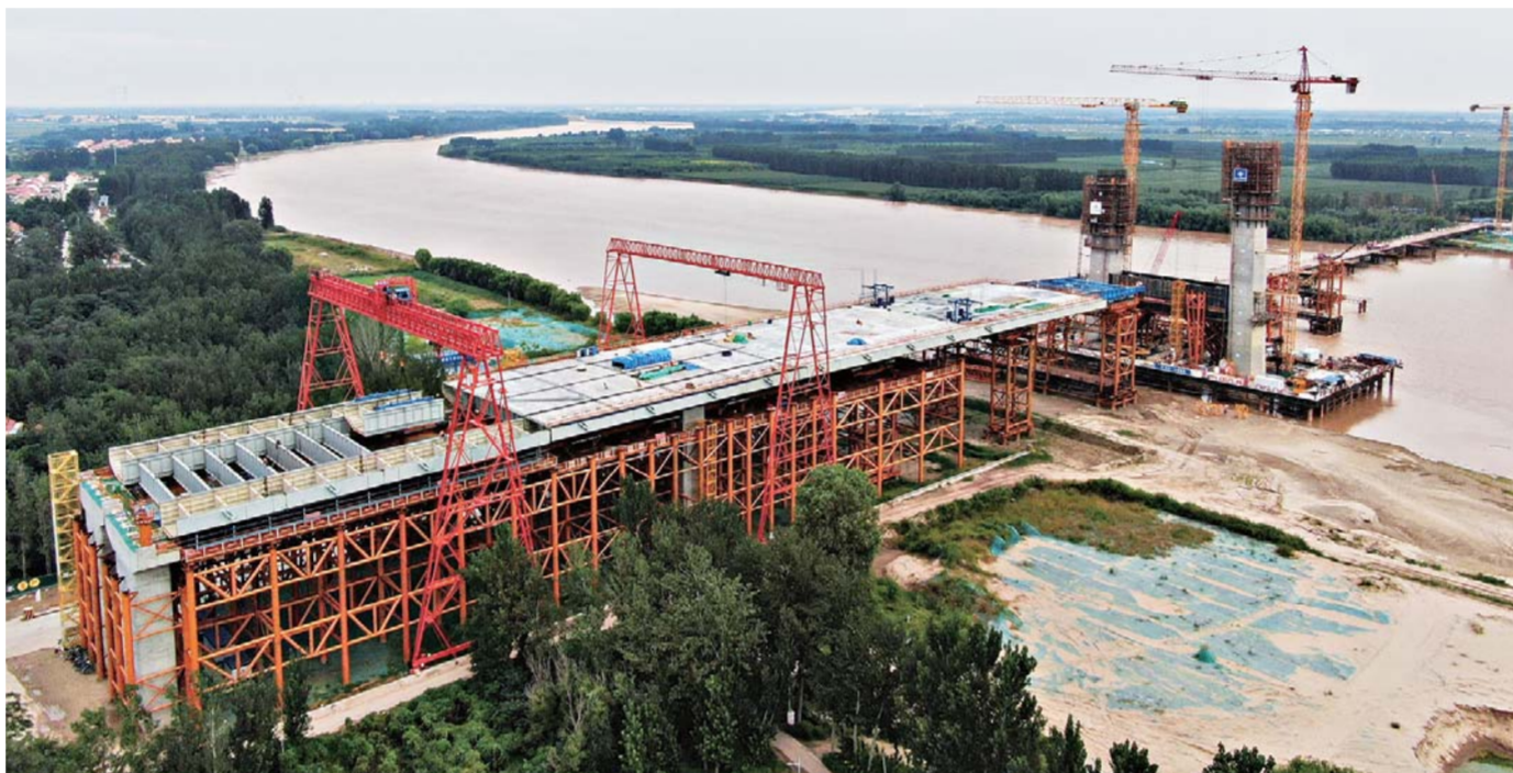
顶推施工-UHPC超高性能混凝土桥面板上桥。
