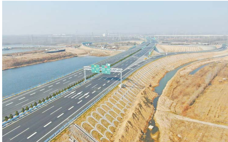
11月26日，由山东高速集团投资建设的董梁高速董家口至威海高速段项目正式建成通车。该项目位于青岛西海岸新区，全长3.86公里，总投资约11.1亿元。
