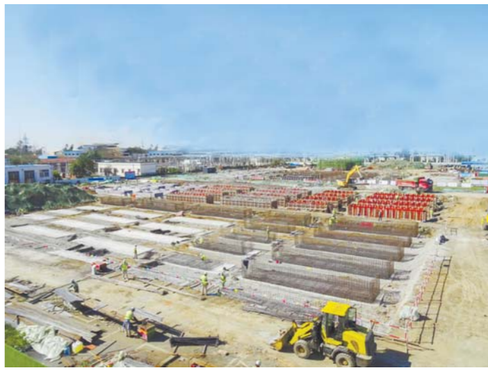
华电滕州101兆瓦/202兆瓦时电化学储能项目施工现场。
