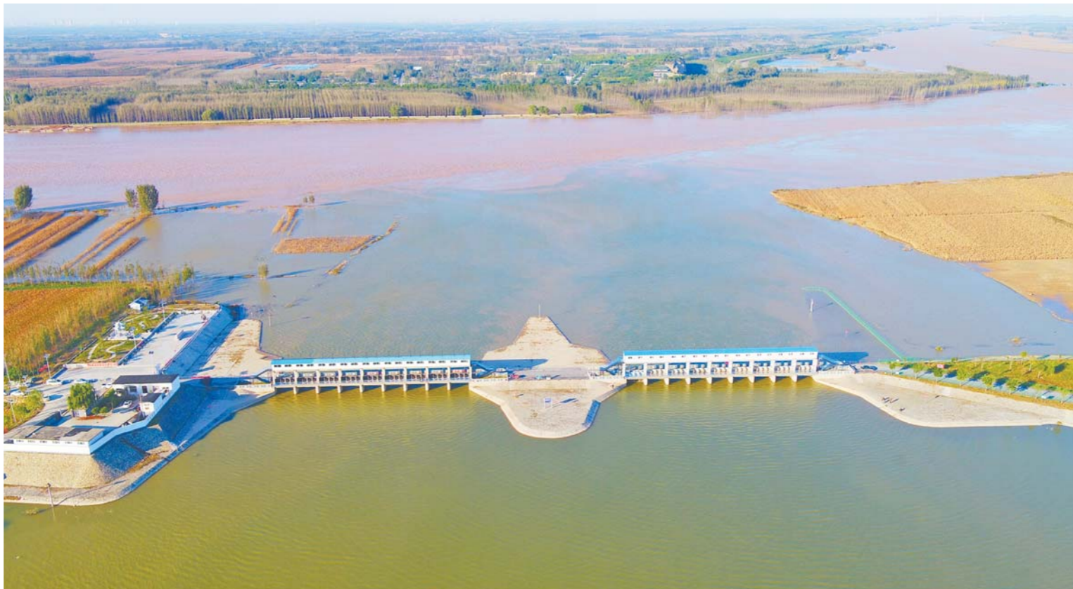
东平湖鹿口防倒灌闸，湖水自此向北流入黄河。（□记者 方全 通讯员 白世玉 报道）
