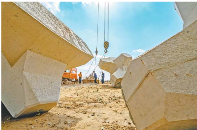
今年秋汛期间，黄河利津段东坝控导现场，防汛人员正在进行投石作业。（□记者 李明 通讯员 王吉祥 报道）
