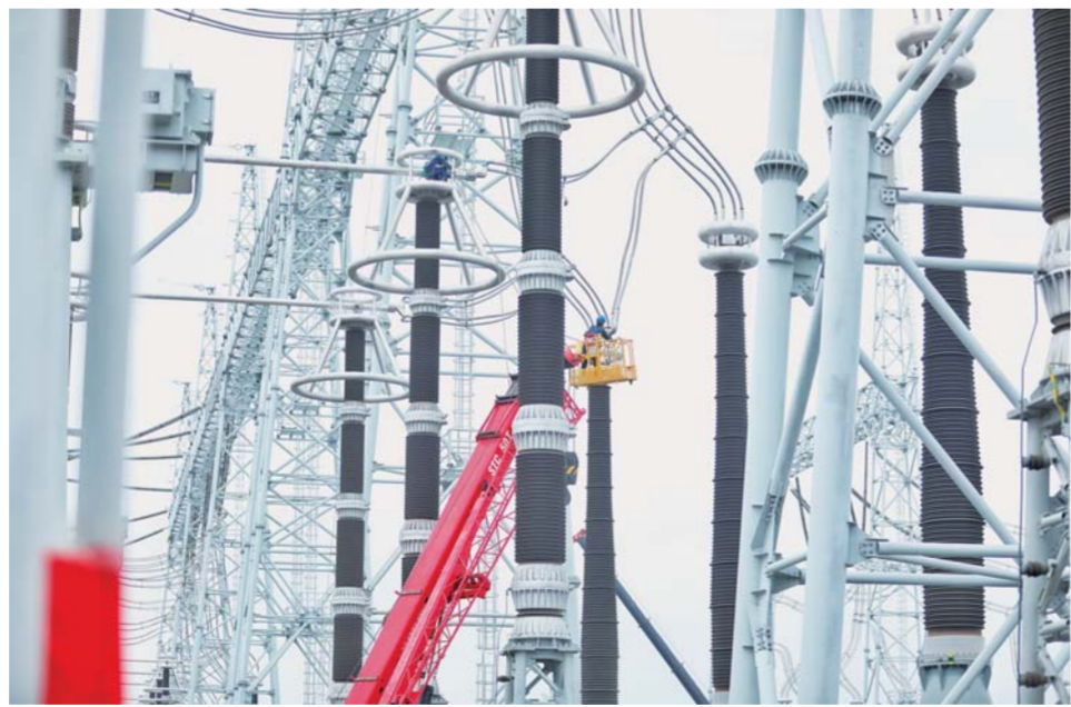
9月28日，国网山东检修公司开展1000千伏微山湖站检修工作。图为检修人员对1000千伏曹湖Ⅰ线进行出线套管到避雷器引线拆除工作。
