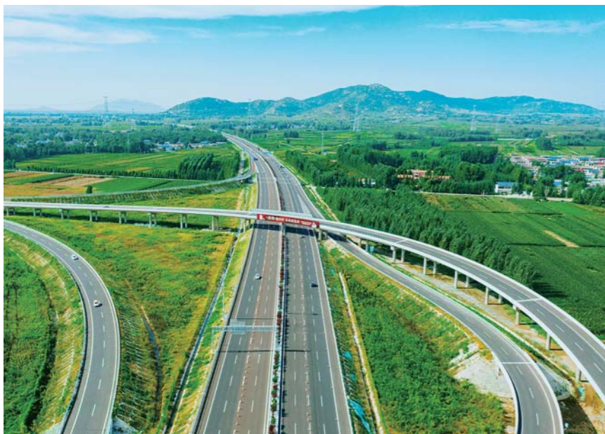
京台高速公路泰安至枣庄段将原有双向四车道拓宽为双向八车道。
