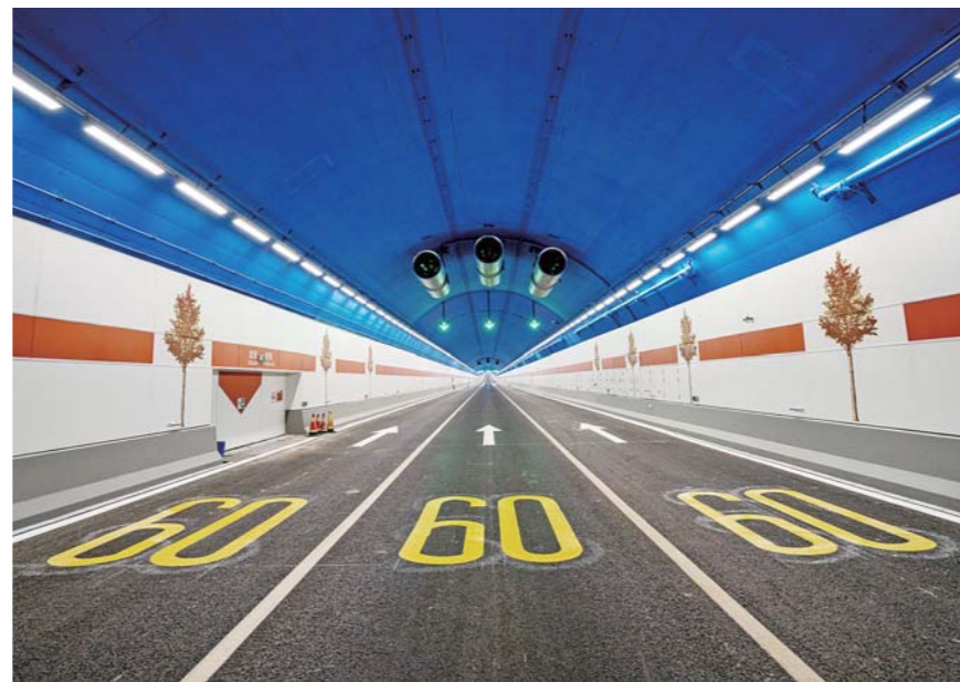
济南黄河济泺路隧道设计时速60公里,开车最快5分钟可穿过黄河。
