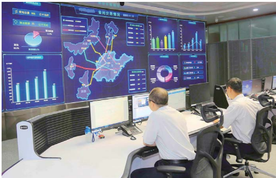
山东电力交易中心信息调度平台。
