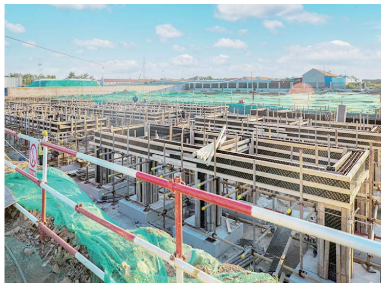
国家电投海阳储能电站示范项目施工现场。
