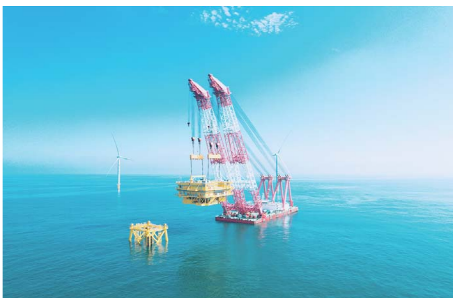
国家电投山东半岛南3号海上风电升压站安装现场。
