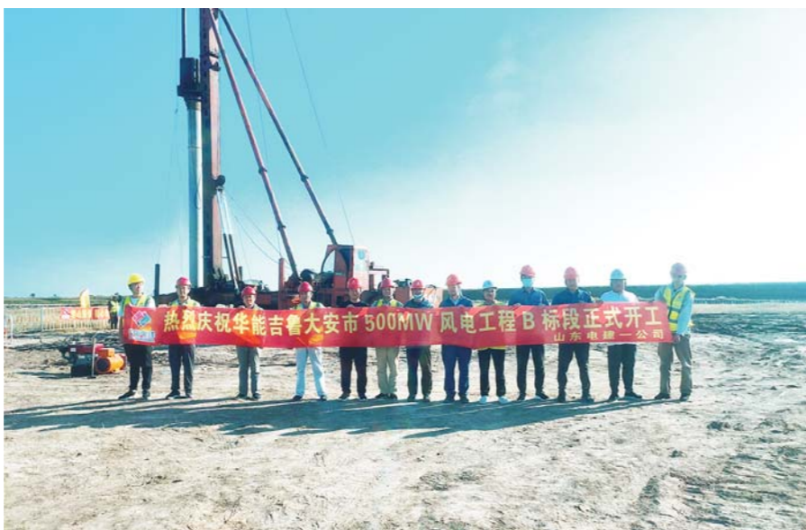
华能吉鲁大安50万千瓦风电项目开工建设现场。
