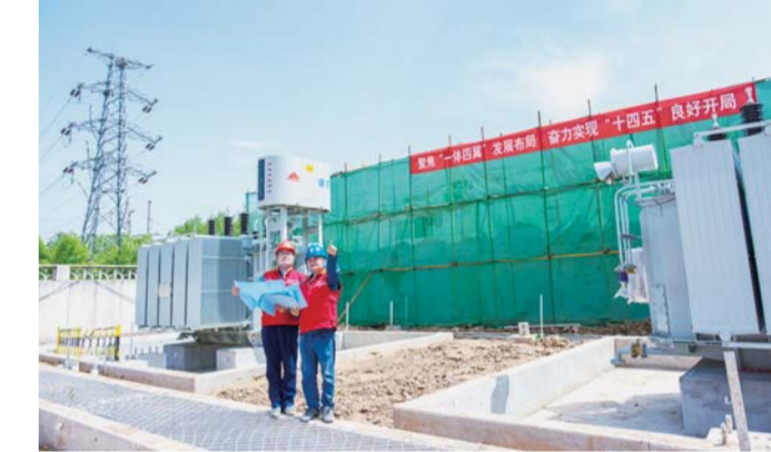
济南供电公司员工在电网建设工程现场对照规划图纸进行比对研究
