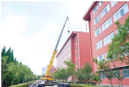
□ 记者 丁兆霞 通讯员 苑克龙 报道 开学在即, 日照大学城正以崭新面貌迎接大学生的到来。去年起, 日照市东港区委、区政府将大学科技园改造提升作为“重点工作攻坚年”的头号任务, 设立6个工作组开进施工现场, 对学生宿舍、餐厅以及园区绿化、亮化进行改造提升。同时东港区泰康街道学苑社区联合多部门, 对辖区内1123家沿街商户按照行业进行分类、分级管理, 为学生食品安全、人身安全提供保障。
