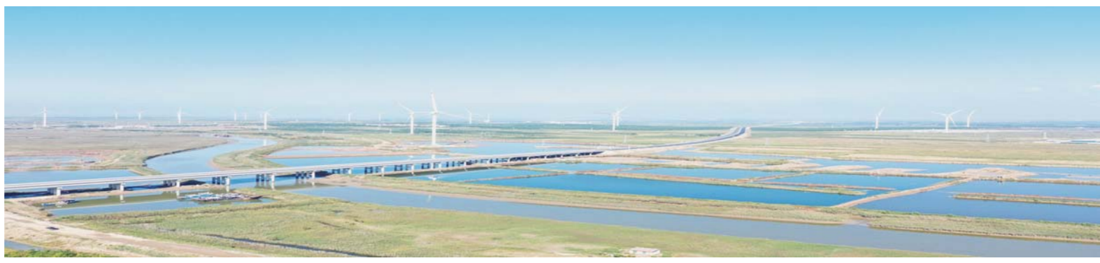
已建成的秦滨高速泰河口大桥
