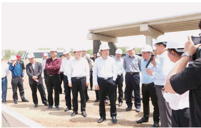
省市交通运输系统领导深入施工一线检查指导工作
