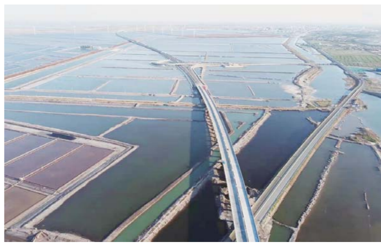
正在施工中的秦滨高速鲁冀界漳卫新河特大桥
