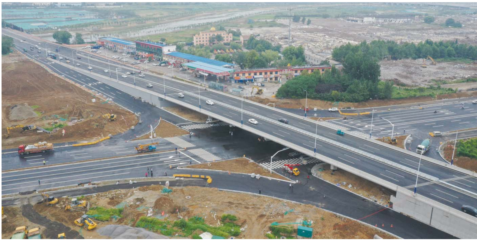
8月21日下午,长城路与岱阳大街立交桥全线通车。长城路与岱阳大街立交桥项目被列入今年泰安市委、市政府为民要办的10件实事。泰安旅游经济开发区把增进民生福祉作为民生工作的出发点和落脚点,全面推进城市道路优化提升。从3月份进场准备,到4月10日开工,再到现在全线通车,长城路与岱阳大街立交桥建设工程仅用时4个月便胜利竣工,跑出了项目建设“加速度”。
