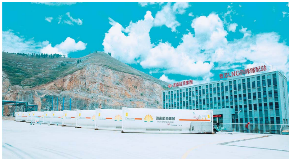
济南南曹范LNG调峰储配站。
