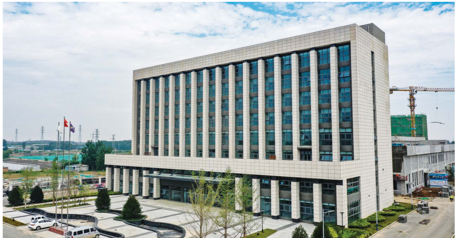
济南先进动力研究所综合楼已交付使用。
