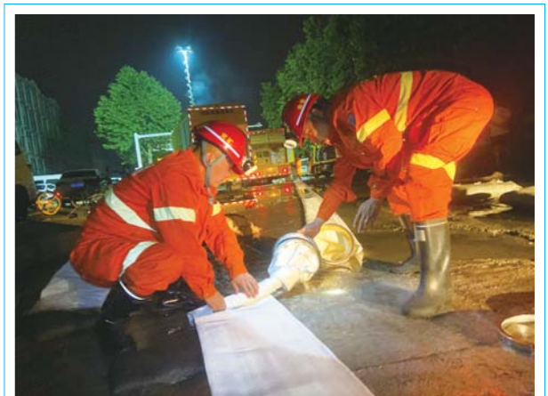
山东能源集团救援队在铺设排水管
