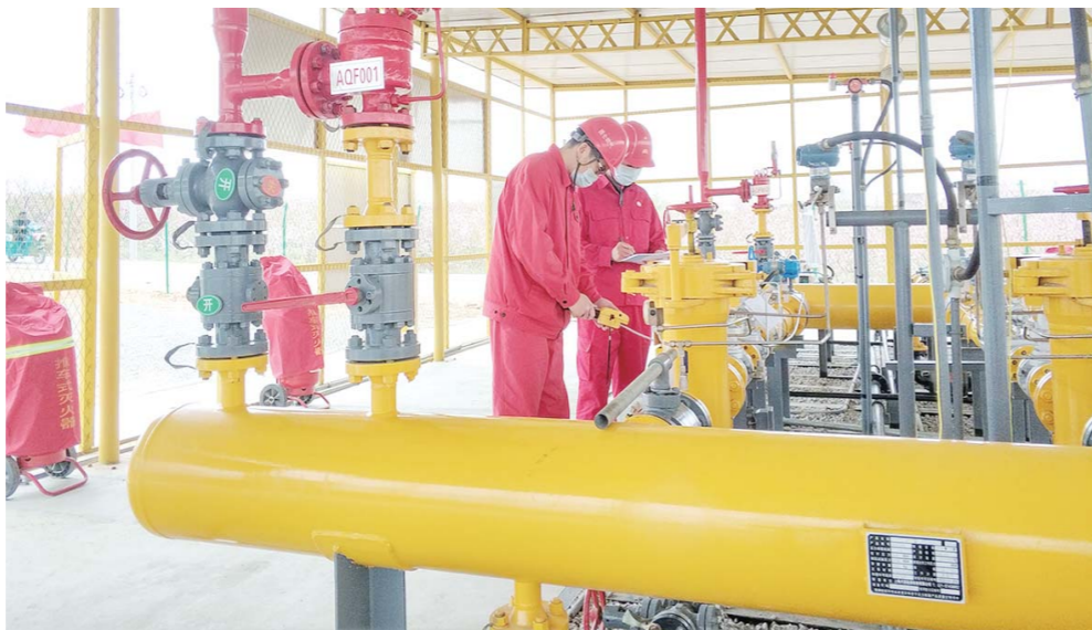
油气公司工作人员正在对天然气管道进行检测维护。
