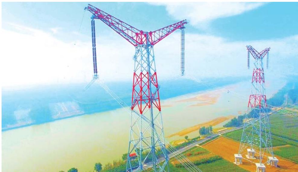
±800千伏锡盟—泰州、扎鲁特—青州特高压输电线路。
