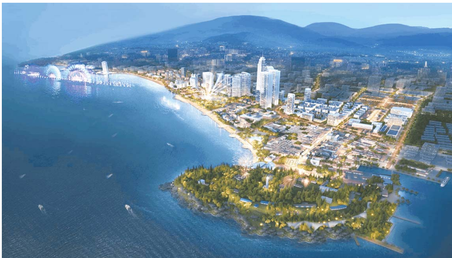
滨海黄金旅游带突出“岛保护、岸治理、湾清洁、线亮丽”主题，锚定关键节点、整合优质资源，打造海洋经济大市建设的样板工程。
