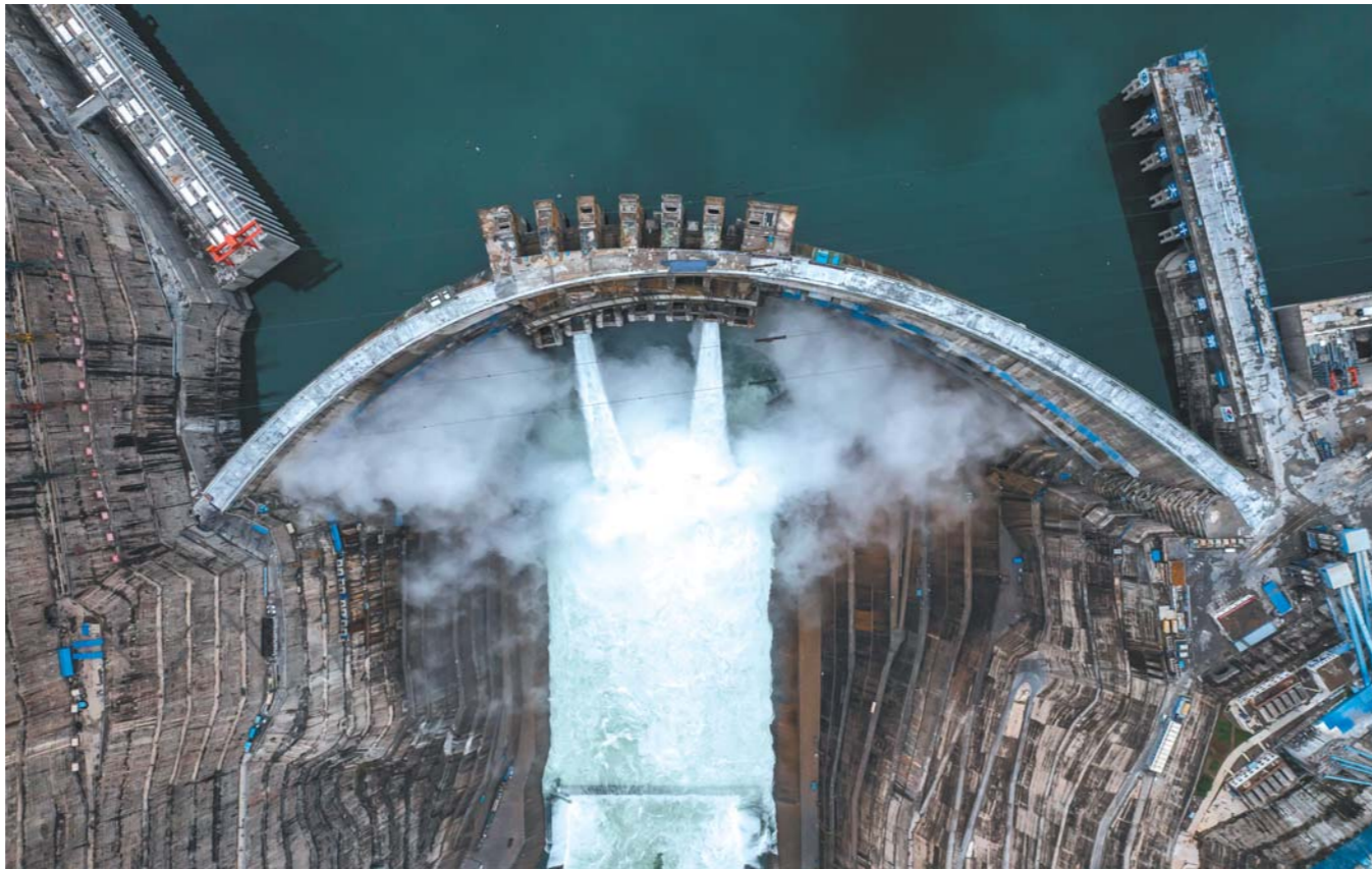
俯瞰白鹤滩水电站(无人机照片,6月28日摄)。
