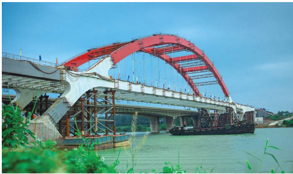
正在建设中的京台高速京杭大运河特大桥。
