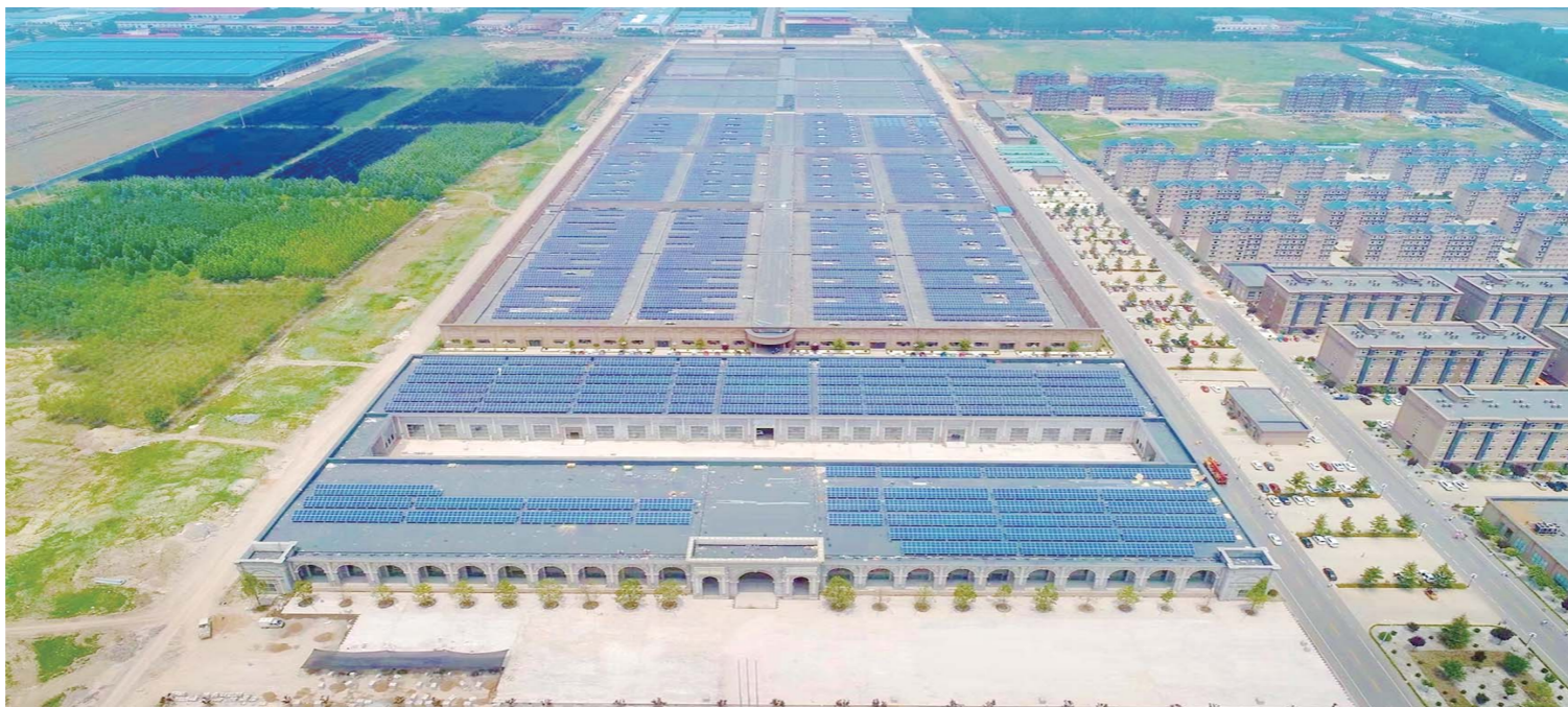
烟台宝桥热力有限公司分布式光伏项目。
