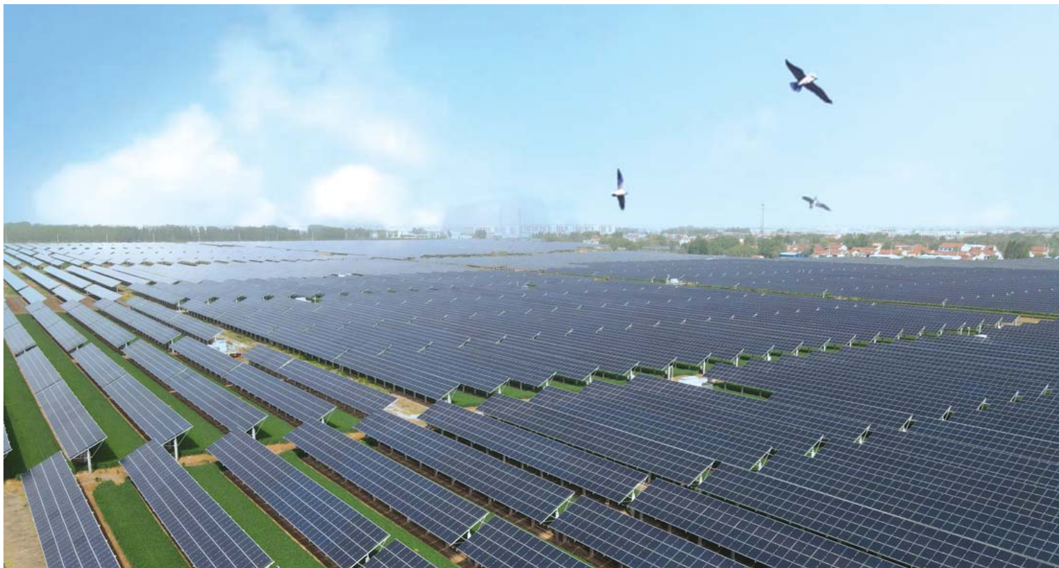
惠民县李庄镇集中式光伏发电项目。
