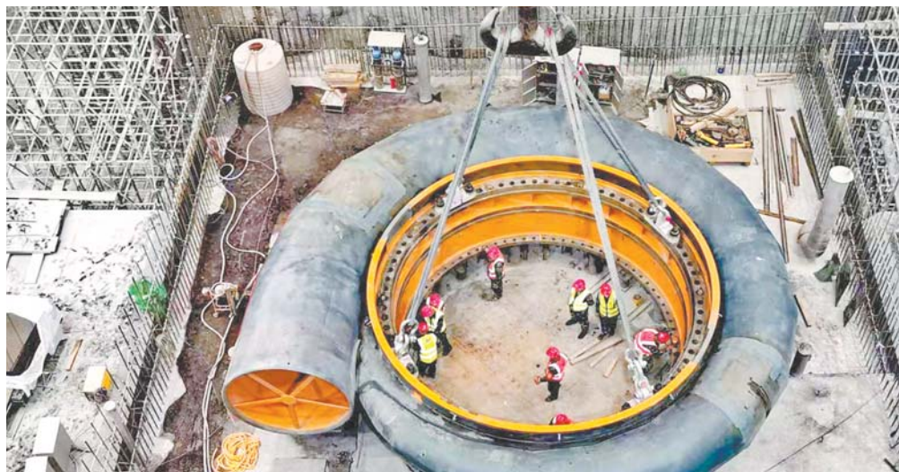
座环蜗壳吊装成功落地。
