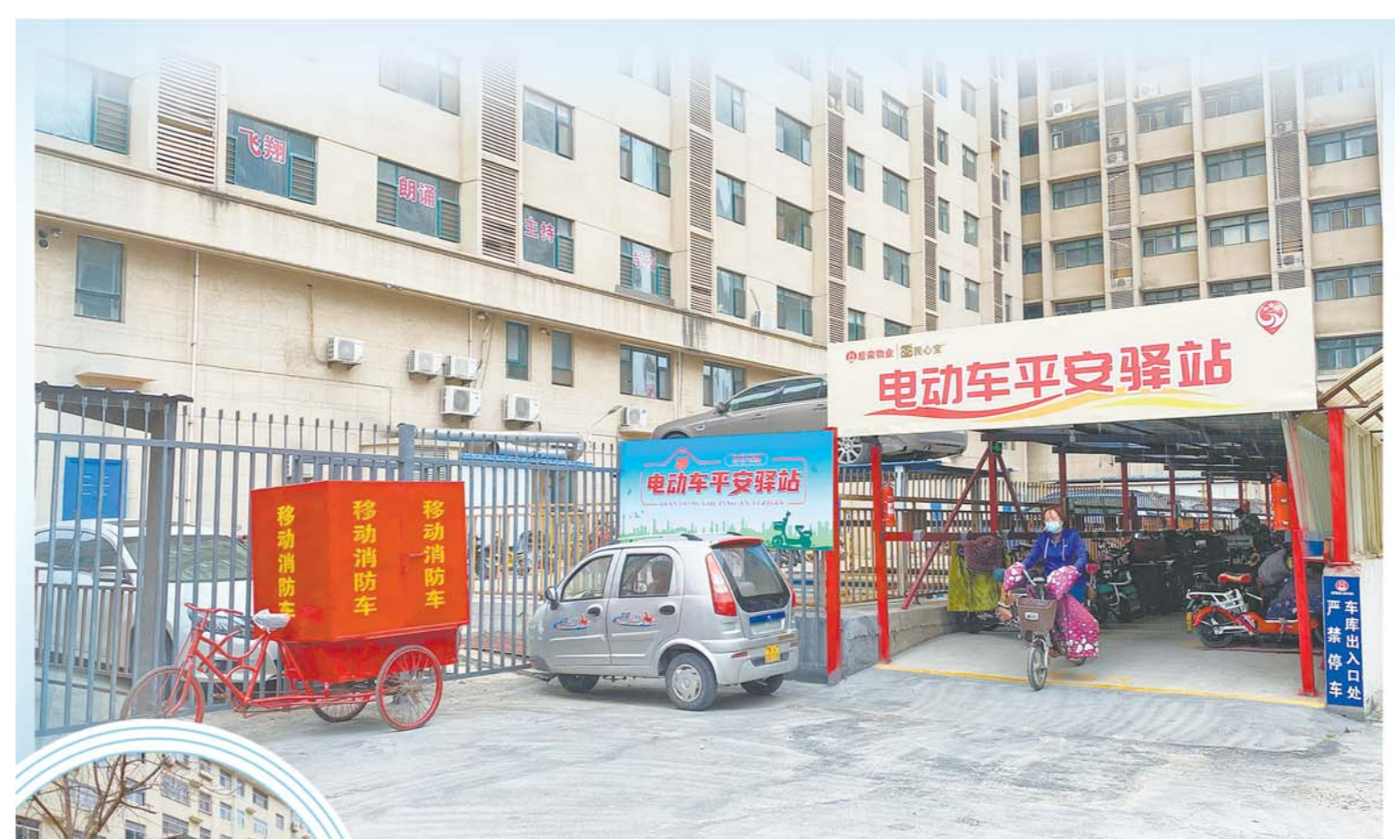
潍坊市奎文区梨园街道后栾花园新建的平安驿站安装了智能充电桩，实现了对电动车的全天候、零距离网格治理。
